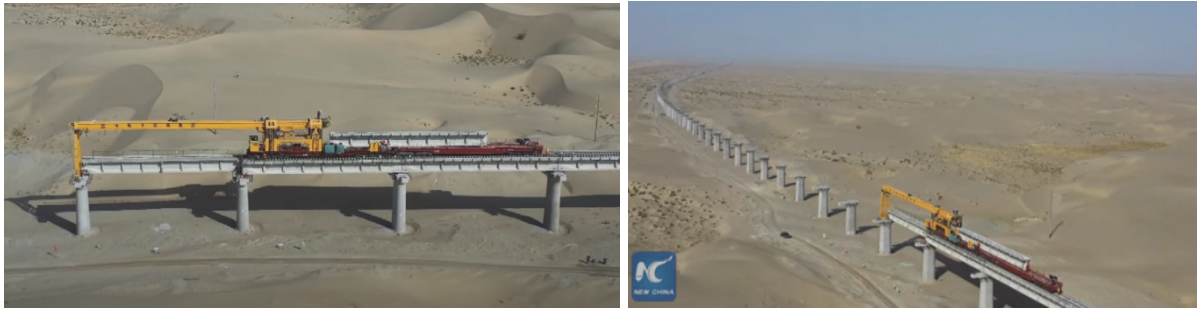
Рис.1. Строительство моста в пустыне для защиты пути от воздействия песка
